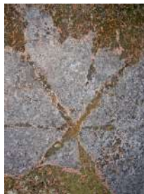
Sprickorna har flera riktningar, vanligen 3 vertikala och en hori- sontell.
