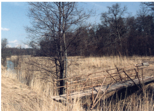
Den nya bron över Fjäturenån, på samma plats där den forntida leden korsade sundet. Bron har genom Naturskyddsföreningens försorg byggts av ALU-anställda. Energiverket har bidragit med ledningsstolpar.
